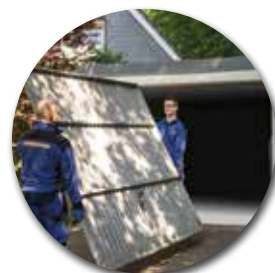
Demontaža i zbrinjavanje otpada
